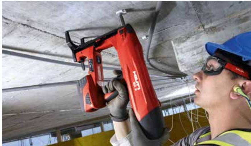
▲ Das Akku-Bolzensezgerät BX 3 ist das erste seiner Kategorie, das ausreichend Energie erzeugt für Anwendungen auf Beton oder Stahl.
